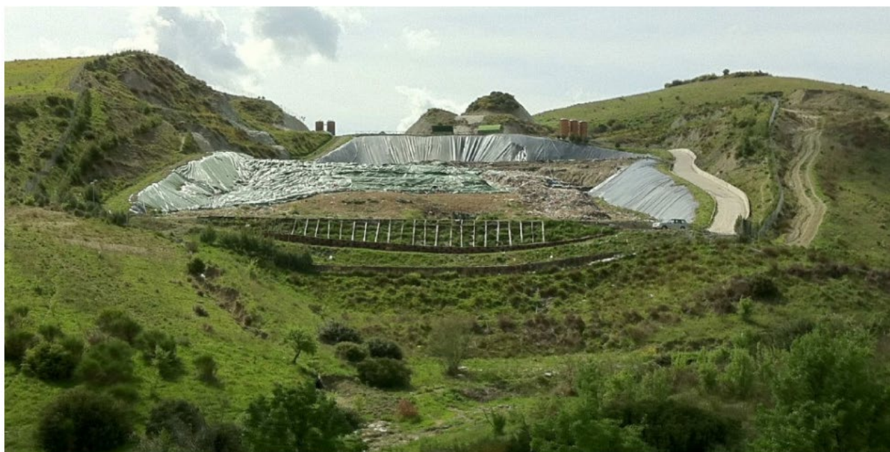
Figura 1 Vista da valle della discarica nella attuale conformazione del bacino
